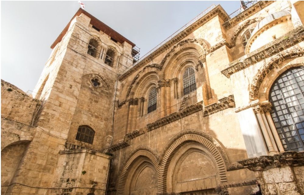
Die Holzleiter an der Fassade über dem Hauptportal steht dort seit dem 19. Jahrhundert.
